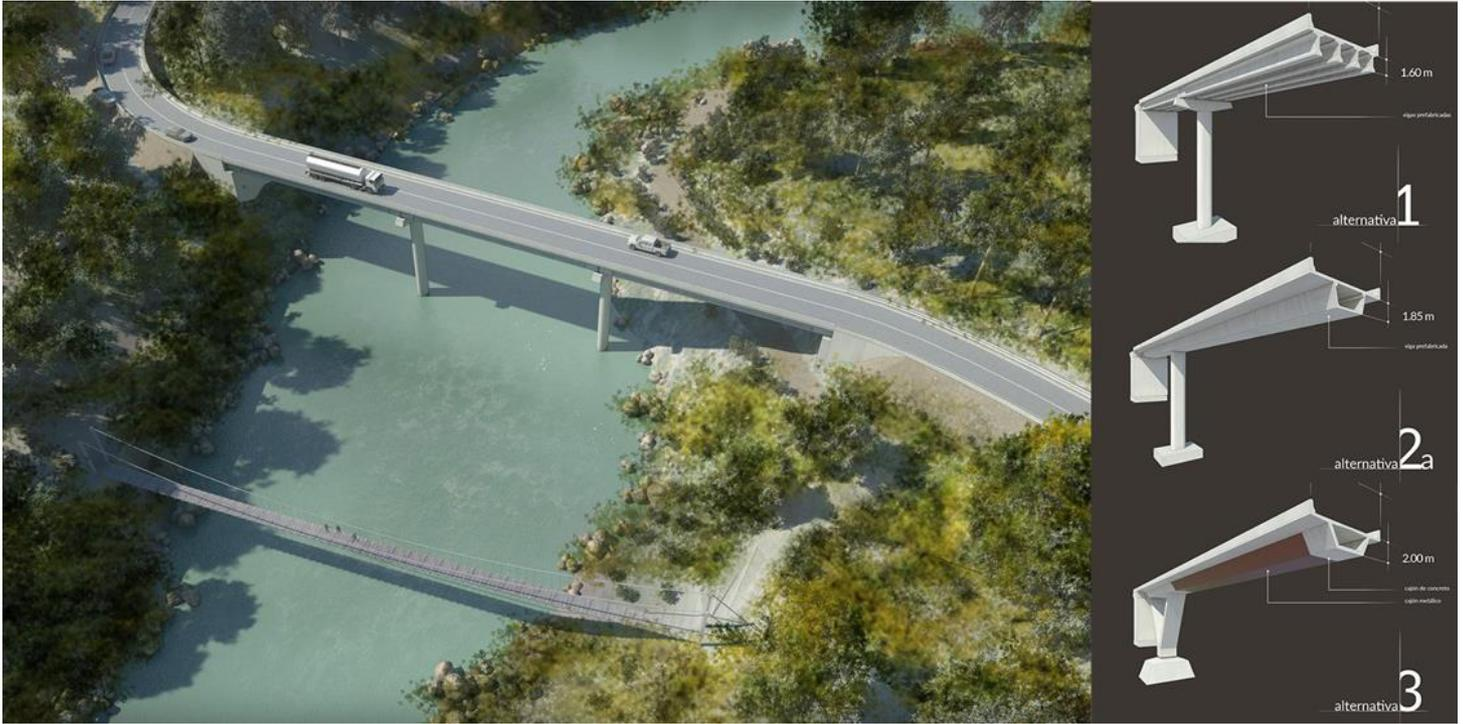
Se trata de un puente sobre el río Torola de 4 vanos de 32,5m cada uno en una zona de alta sismicidad. De entre las alternativas propuestas, la tipología elegida fue un tablero de vigas. El tablero es mixto de 9m de anchura y está compuesto de 4 vigas metálicas doble T de 1,10 m de canto y una losa superior de hormigón de 0,25 m de espesor.
